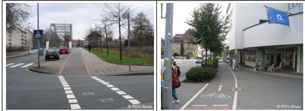
Abb. 2-4: Radwege ohne Benutzungspflicht: Baulich eindeutig (links) und Kennzeichnung durch Trennlinie und Fahrradpiktogramm (rechts)
