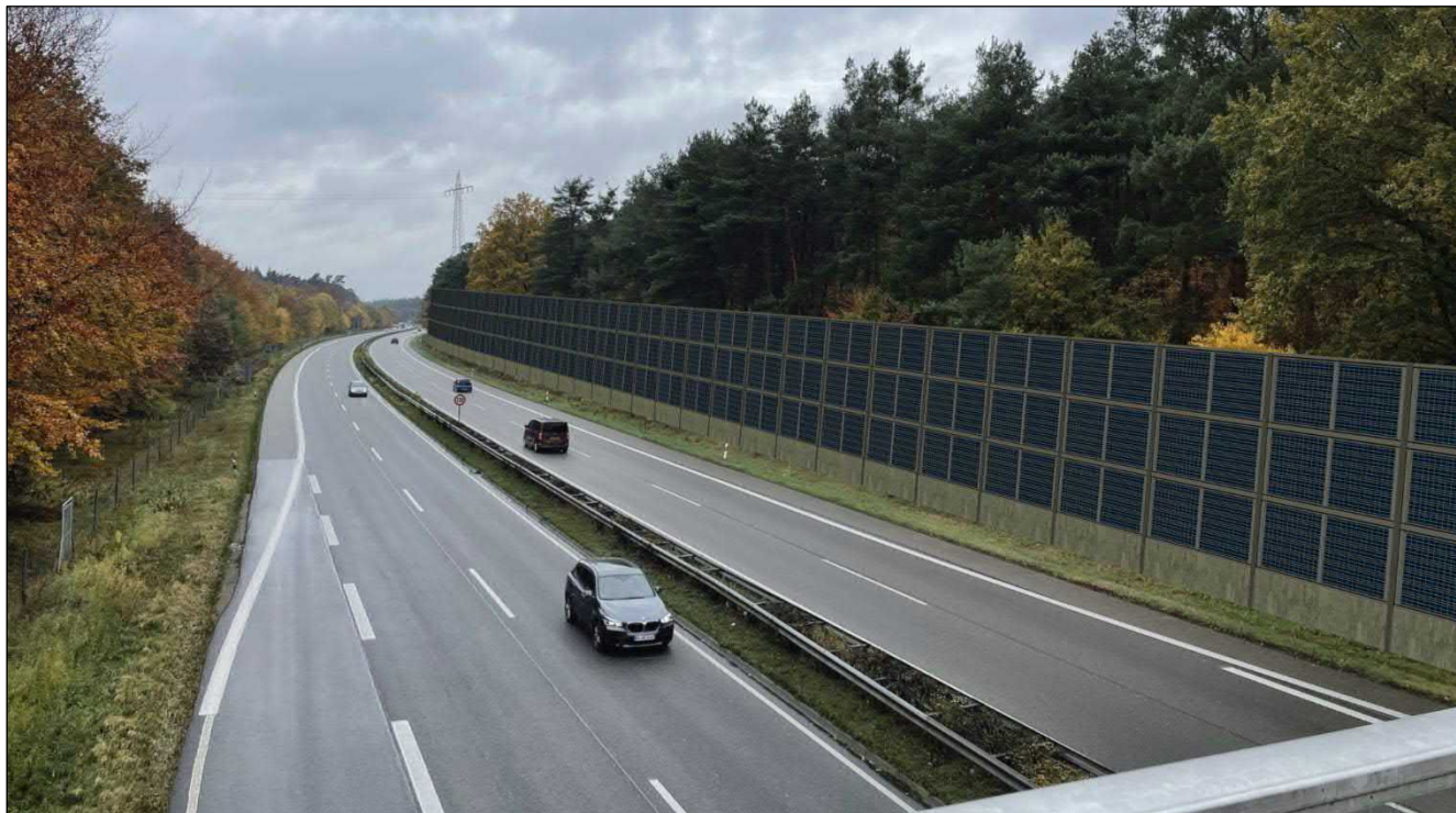
Abbildung 18 Fotocollage Pv-Lärmschutzwand im Abschnitt 1.1
