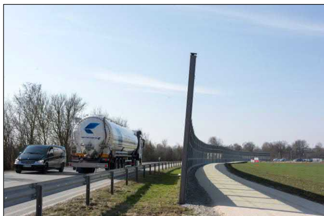
Abbildung 13 Pv-Lsw Seitenansicht mit St2550 und Wartungsweg
