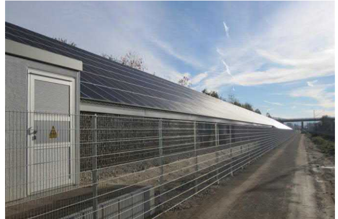
Abbildung 9 Pv-Lsw Neumarkt i.d.OPf. Blickrichtung nach Westen
