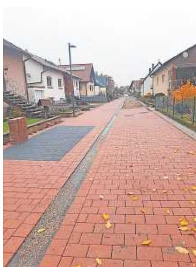
Die Straßenbauarbeiten in der Badstraße und Teilen der Ringgasse begannen am 14. Februar. Im Zuge der Arbeiten wurden alle Versorgungsleitungen wie Abwasser, Wasser, Strom und Telefon erneuert.
