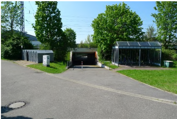
Bild 31: Zugang zur Straßenbahn
