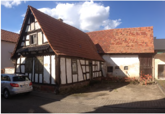
Bild 20: vom Verfall bedroht: wertvolles Gebäude in der Rupprechtstraße
