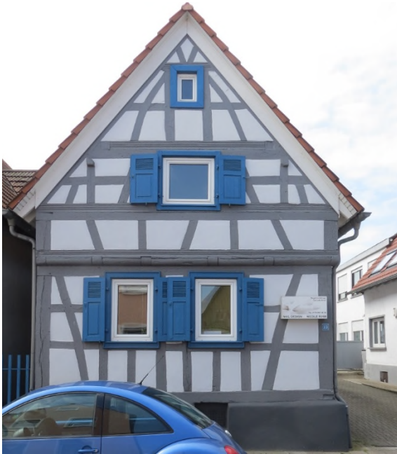
Bild 2: altes Fachwerk in der Luitpoldstraße
