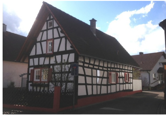
Bild 21: saniertes Haus in der Wilhelmstraße
