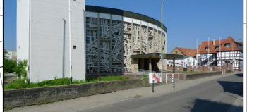
fehlende Aufenthaltsqualität an der Kirche
