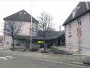
Außenwand Grundschule, Turmstraße 2
