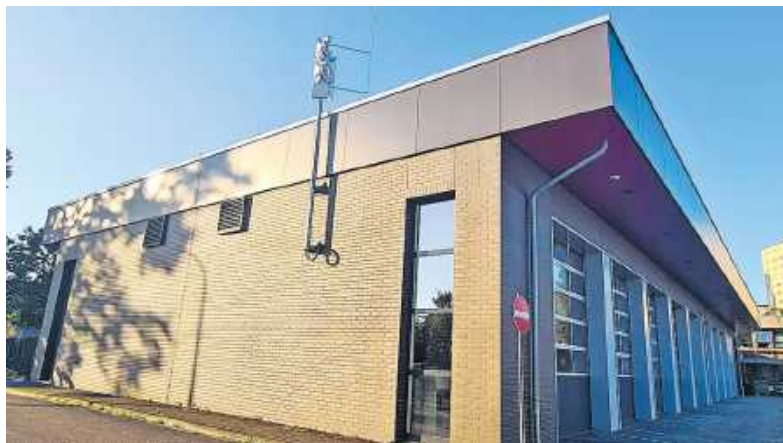
Sirenenanlage auf dem Feuerwehrgerätehaus in Wörth (Foto: Stadt Wörth am Rhein)
