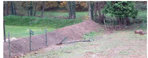
Verwallung / Mauern BCE, www.hochwassermanagement.rlp-umwelt.de
