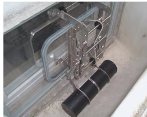
Automatisch schließende Vorsatzscheibe Hochwasserschutzfibel, 2022
