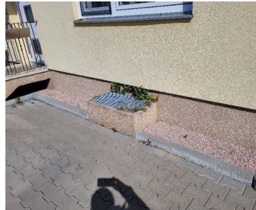
Konstruktive Erhöhung von Lichtschächten
