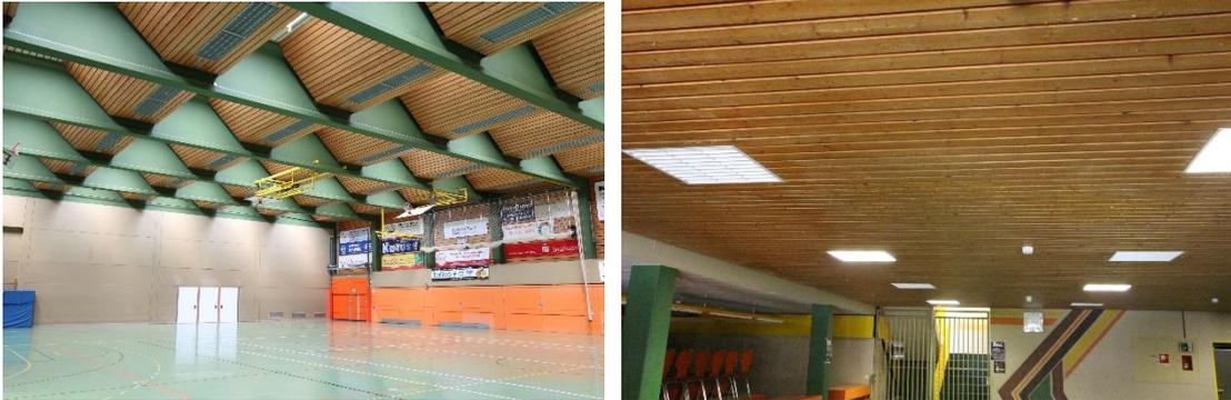
Die Dämmungen unter solchen Decken sind erfahrungsgemäß KMF-belastet. Ein fachgerechter Rückbau und Neuaufbau mit gesundheitsunbedenklicher Dämmung ist hier Teil der notwendigen Sanierung.
