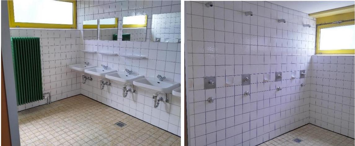
Es wird vorgeschlagen, die Fliesen am Boden einschl. Estrich und an den Wänden zu erneuern. Die Leitungsführung der Sanitärobjekte muss neu aufgebaut werden, alle Rohre aus den Wänden entfernt werden. Die Versorgungsleitungen können revisionierbar neu unter der Decke verlegt werden.
