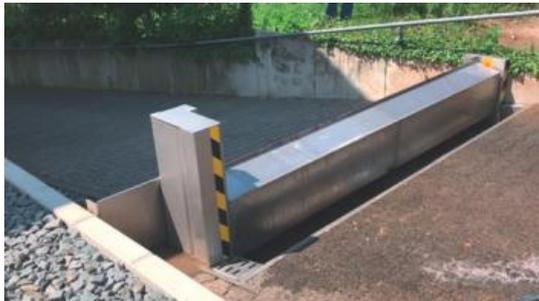
Mobiles Klappschott ([www.klappschott.de](http://www.klappschott.de))
